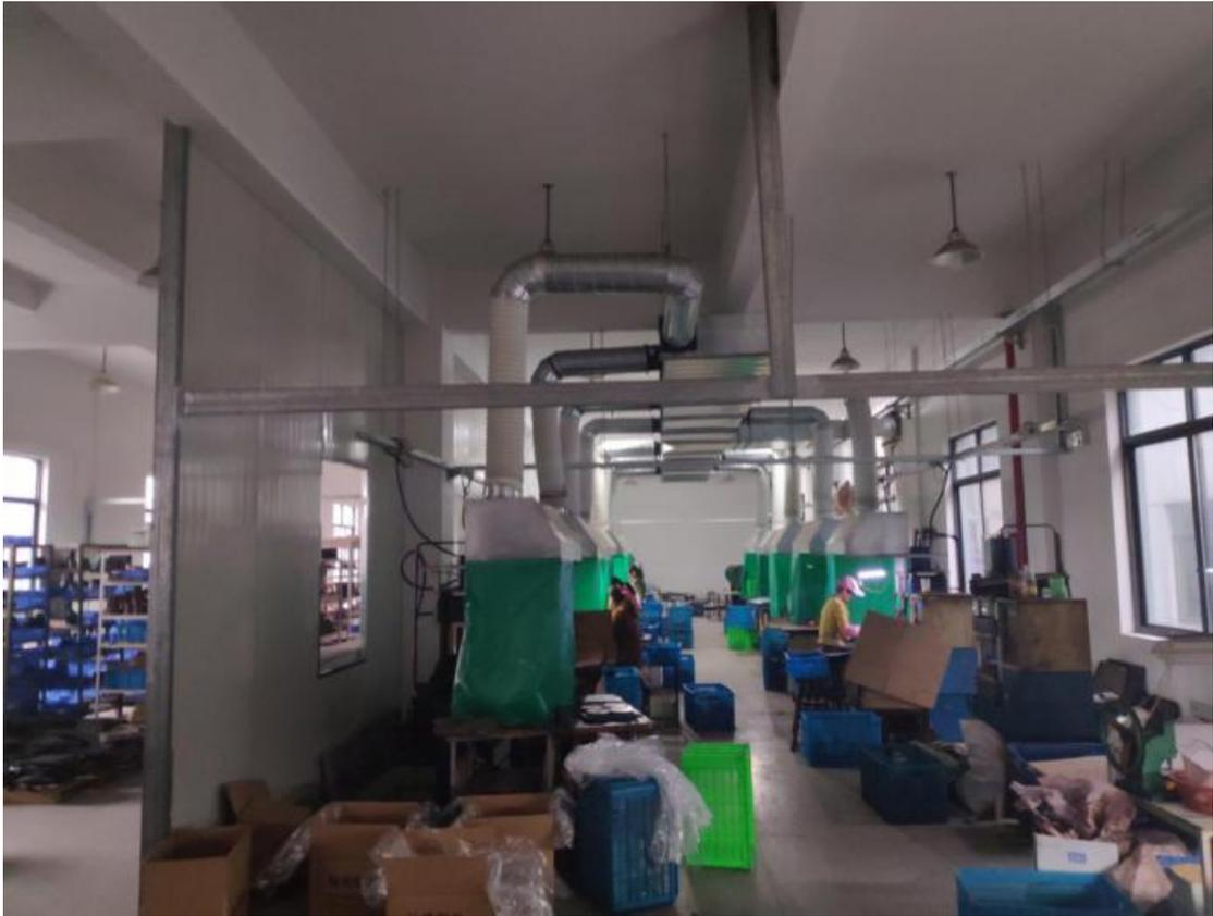
图 4-3 压膜废气处理设施
