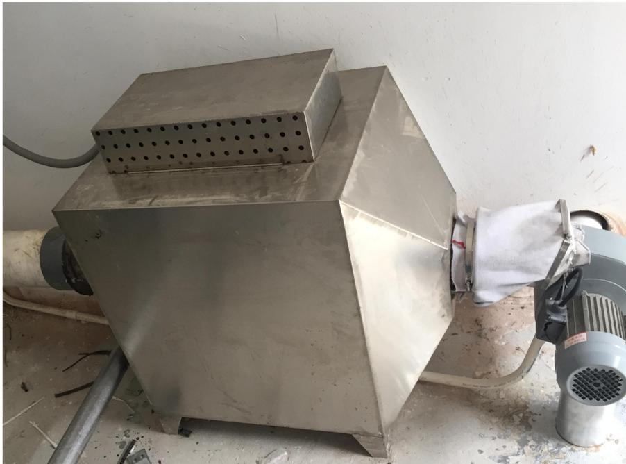
图 4-3 污水站废气处理设施
